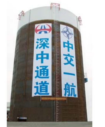
近日,深中通道西人工岛项目完成首件钢圆筒制作。该钢圆筒直径28米,高38.5米,重637吨。王田 摄影报道
