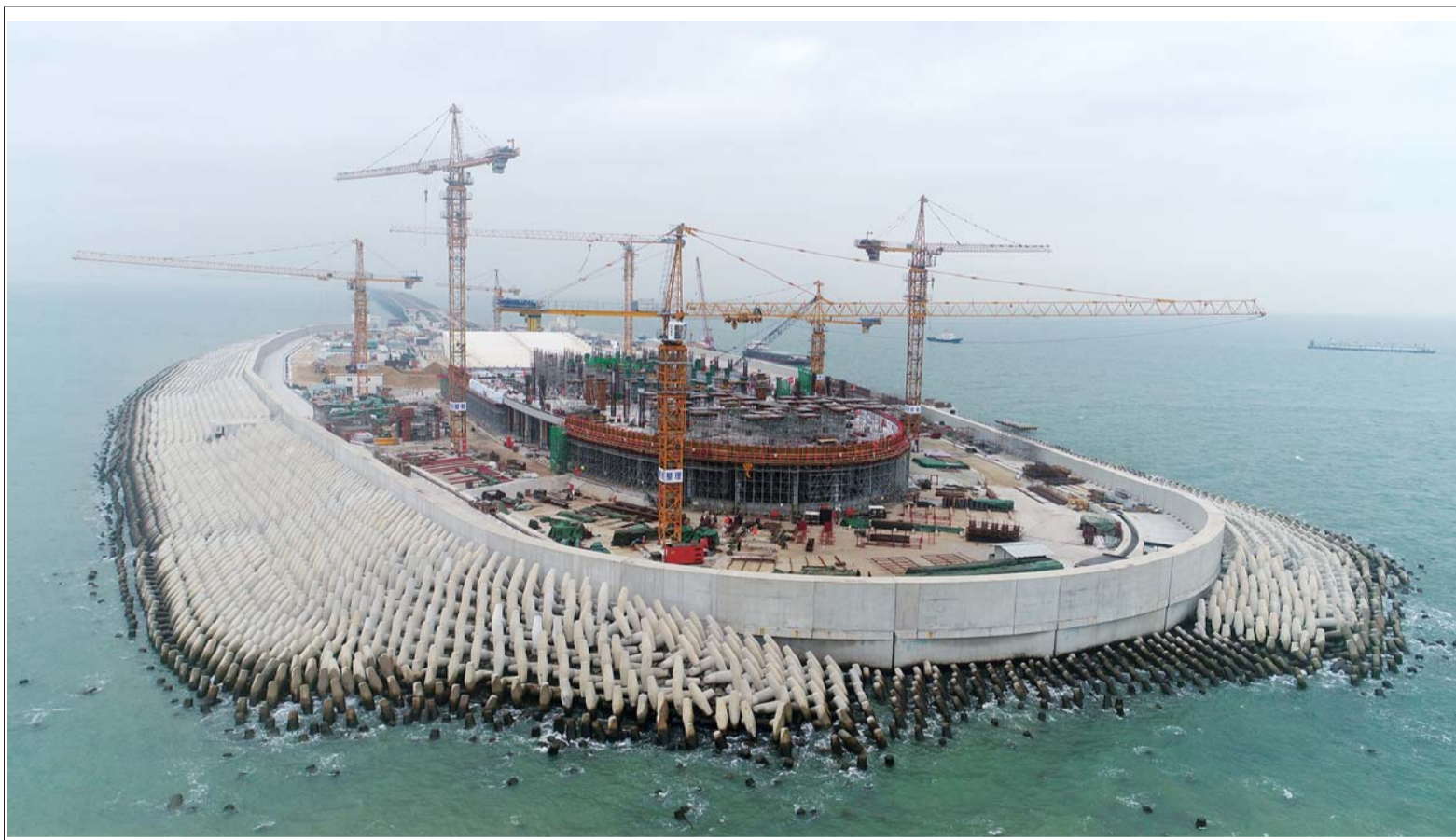
3月31日,一公司承建的港珠澳大桥西人工岛主体建筑首层封顶,珠江口“地标性建筑”初现雏形。西人工岛主体建筑共分三层,建筑面积为2万平方米,全部采用装配式及清水混凝土施工工艺,主要包含办公室、监控室及宿舍等设施。董永贺 摄影报道
