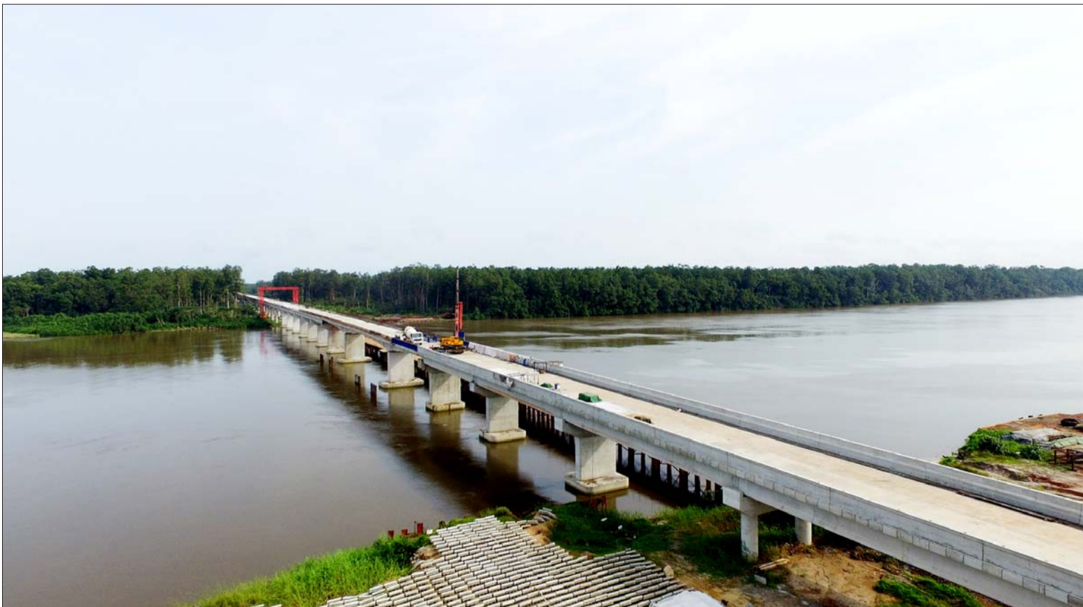
近日,四公司加蓬项目部承建的加蓬 PO 公路工程推进顺利。其中,奥果韦河特大桥梁架完成 620 片,路基填砂完成 90%,预计大桥将于今年底全部贯通。图为奥果韦河特大桥梁南汉河段桥面及防撞墙施工。 郝英 摄影报道
