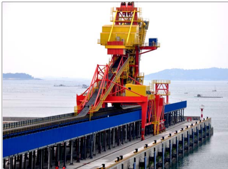
近日,五公司承建的国投满洲湾煤炭码头装船泊位(东吴作业区14号泊位)及二期一阶段工程第三批交工工程顺利通过验收。 徐龙杨 杨照东 摄影报道
