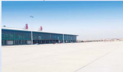
2016年建设襄阳机场站坪 杜振河 摄
