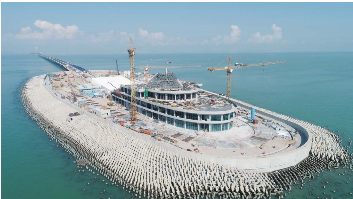
近日,港珠澳大桥西人工岛面室外工程全速推进,主体建筑室内装饰、装修等有序开展,西人工岛建设进入全面攻坚收尾阶段。董永贺 摄影报道
